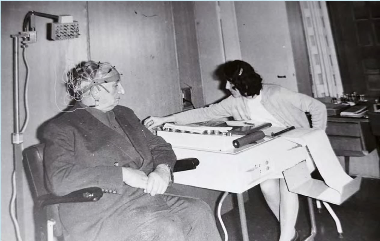
EEG-Ableitung im Untersuchungsraum mit abgeschirmten Wänden
