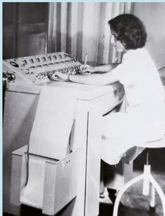
1966, Bärbel Rothe am röhrenbestückten Schwarzer EEG. Der Patient sitzt zur Ableitung in einer Faraday'schen Kabine
